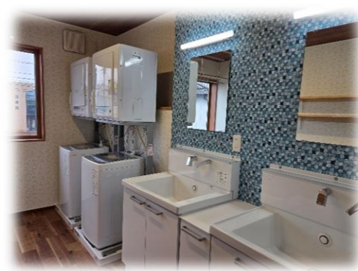
各階に2台ずつある 洗濯機と乾燥機
